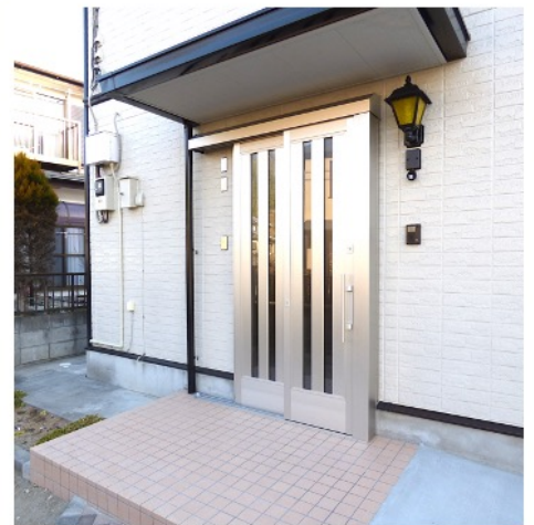
元々、開き親子ドアだった玄関ドアを、車椅子に乗ったまま一人でも容易に開閉できる2枚の引き戸にリフォームしました。
